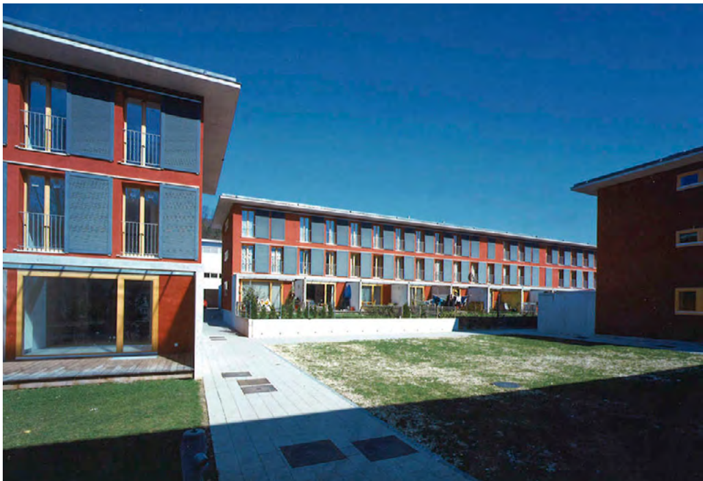
Ringermatten Zwingen. Reihenhause-Siedlung mit günstigem Wohneigentum. Gartenseite.
